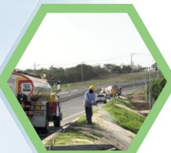
Esta medida contempla la revegetalización de taludes tanto de corte como de terraplén y construcción de obras hidráulicas como cuentas y zanjas de coronación, con el fin de mantener su estabilización, prevenir procesos de erosión y recuperar las áreas intervenidas.
