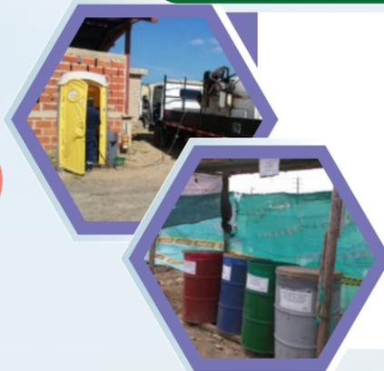
Instalación de puntos ecológicos en los frentes de obra para la clasificación y almacenamiento temporal de residuos, la instalación de un baño portátil por cada 15 personas, la disposición de residuos con proveedores autorizados y capacitación al personal en manejo de residuos líquidos y sólidos.
