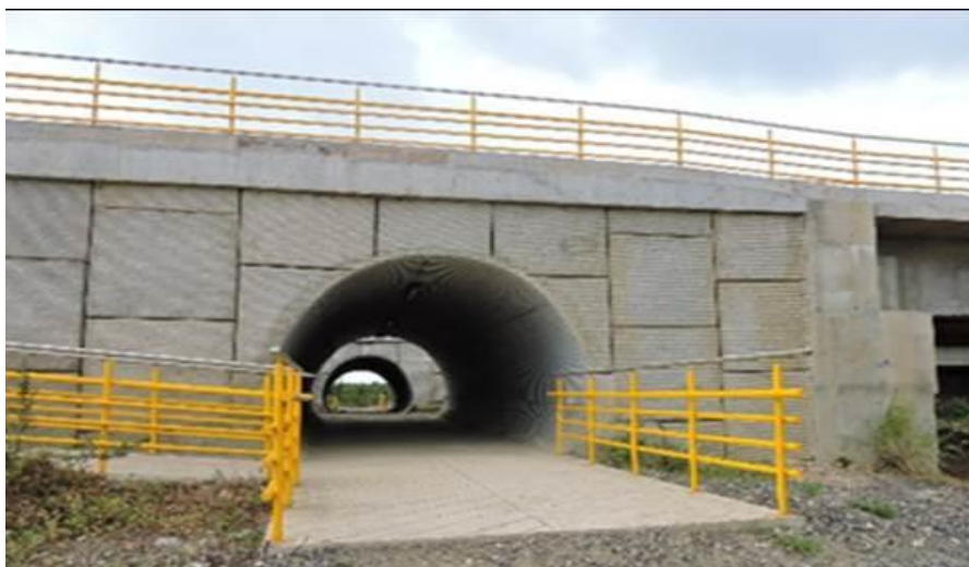
Figura 13 Paso Peatonal Sector Tierra Baja
