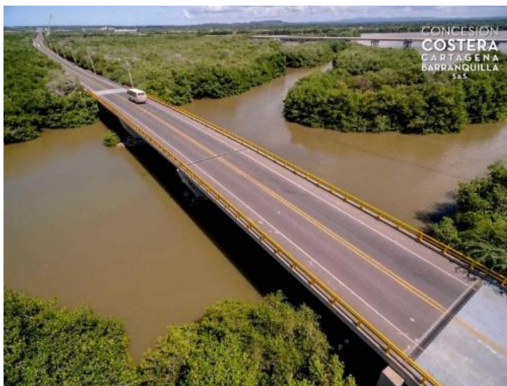
Figura 5. Vista general puente La Boquilla
