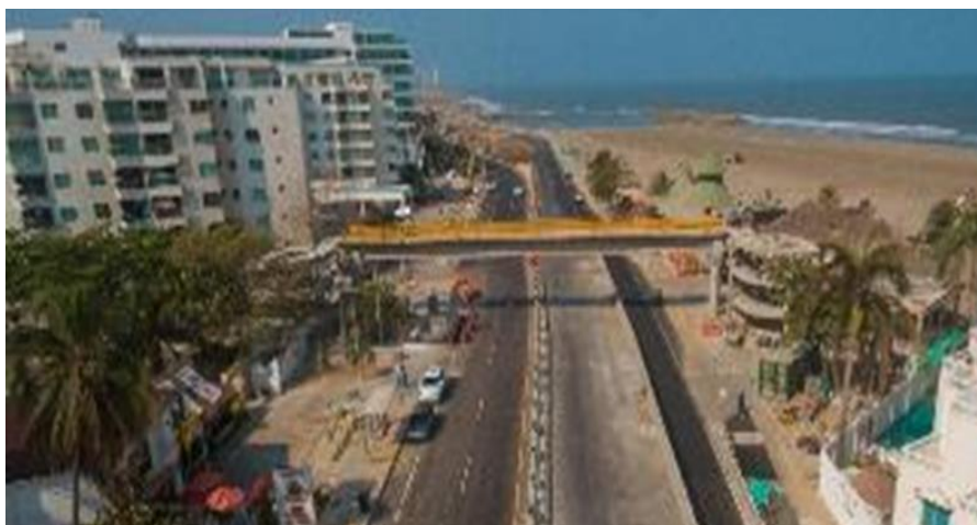
Figura 14. Paso Peatonal Sector Blas el teso
