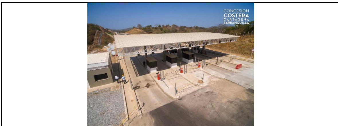
Figura 23. Estación de Peaje – UF6
