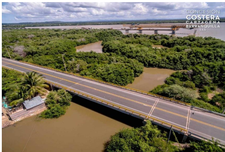
Figura 4. Vista general Puente caño Luisa UF 1
