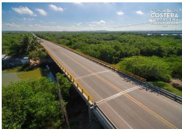
Figura 7. Vista general puente Brazuelo
