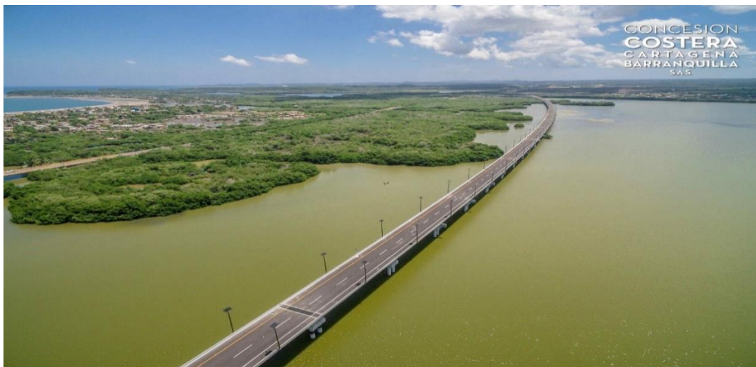
Figura 9. Gran Viaducto Sector 1 UF2
