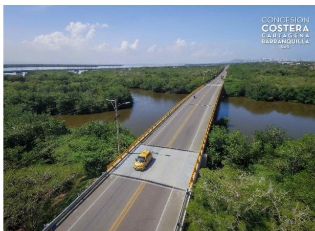
Figura 6. Vista general puente El Cañón
