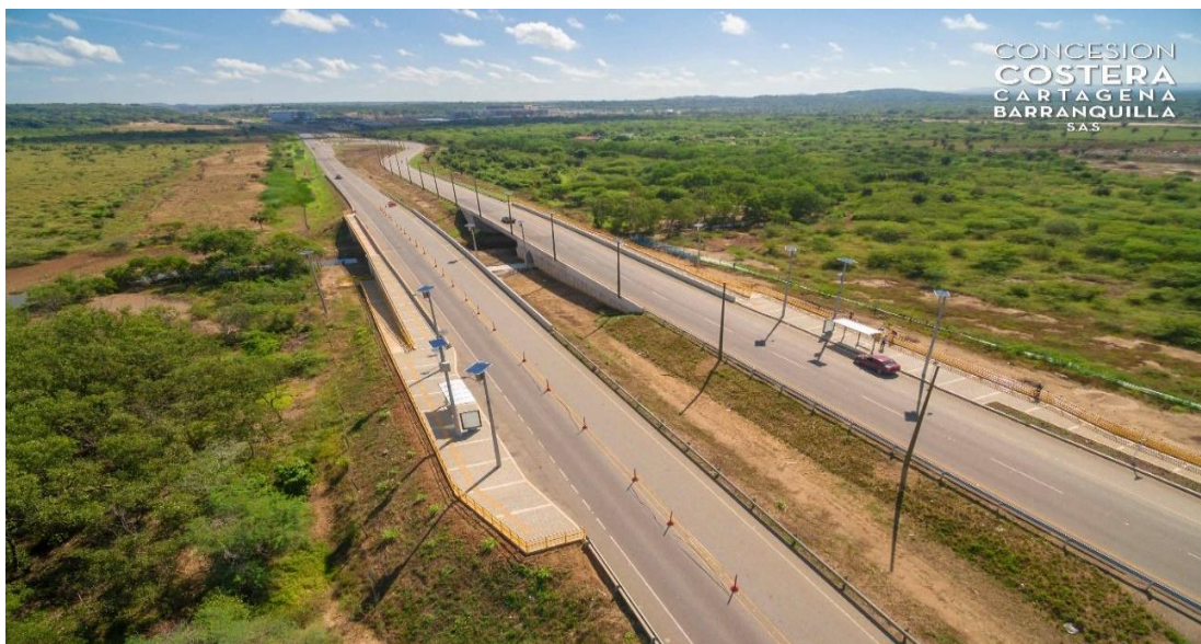
Figura 11. Puente Caño Mesa Sector 2 UF2
